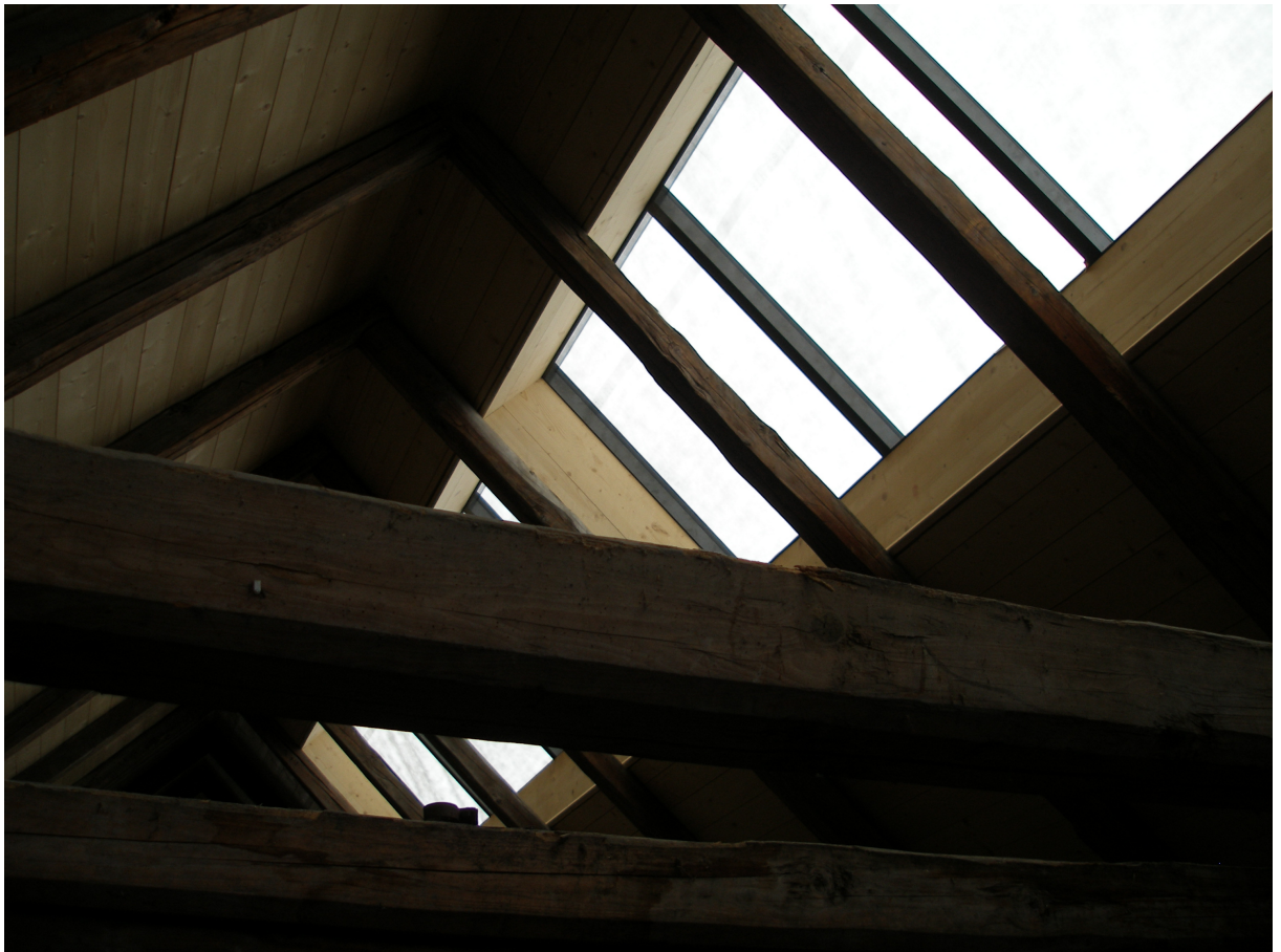
Dachflächenverglasung für späteren Ausbau
