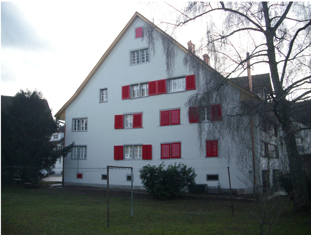
Nach Dach- und Fassadensanierung 2009
