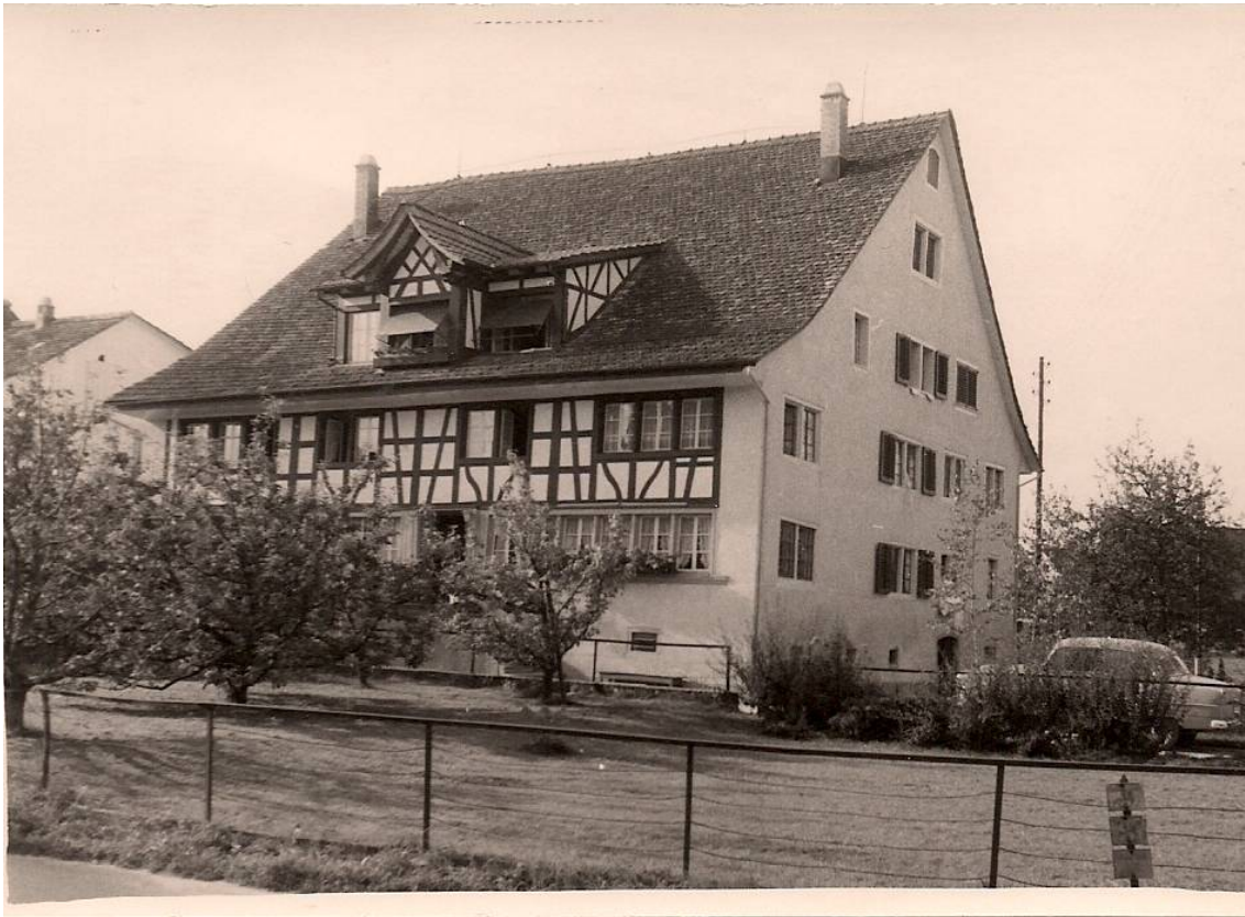
Bild um ca. 1956 (nach Umbau durch E. Frick)
